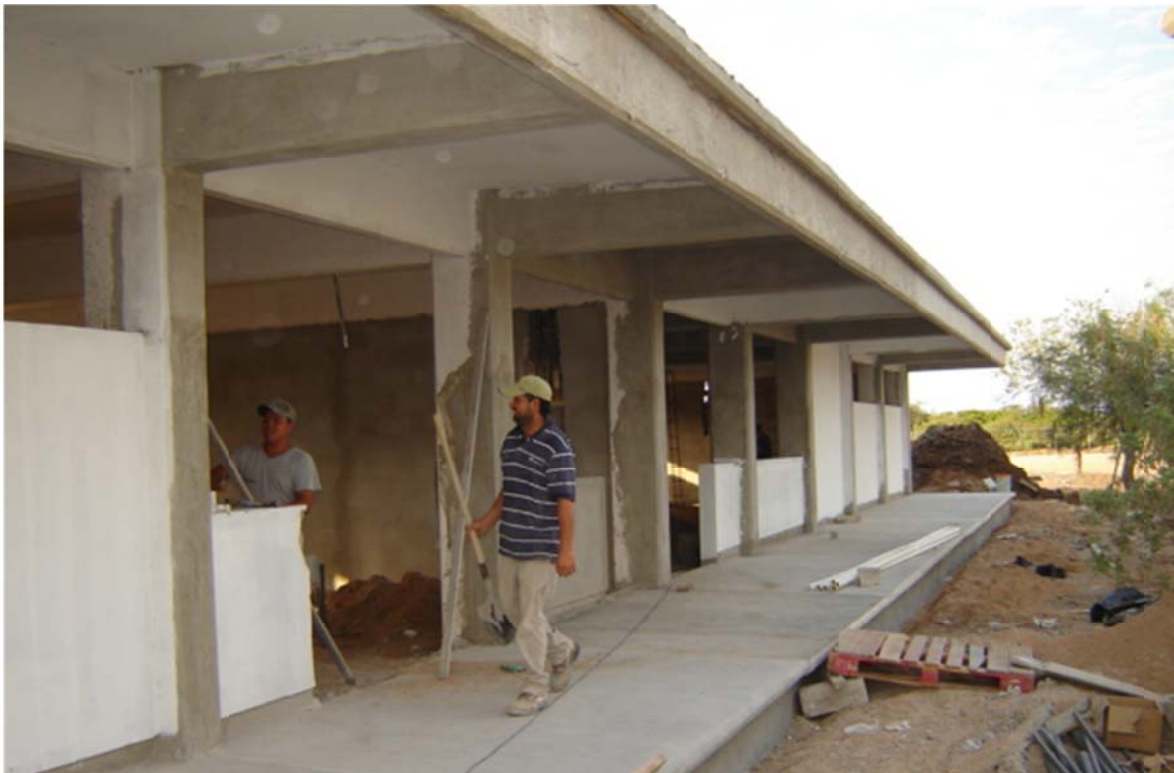
Centro de rehabilitación de fauna marina en construcción, Unidad Pichilingue.
