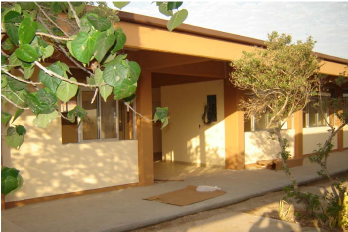
Edificio administrativo y cubículos, Unidad Pichilingue.
