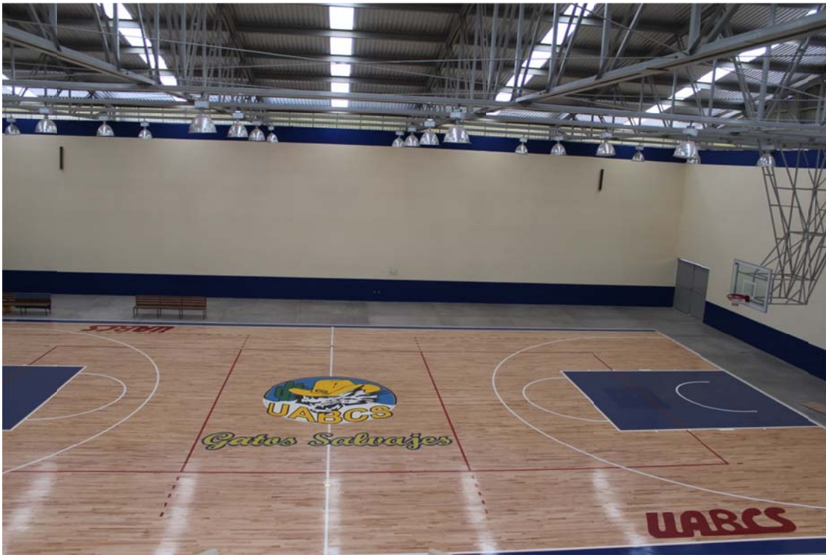
Sustitución de la duela del Gimnasio Auditorio.
